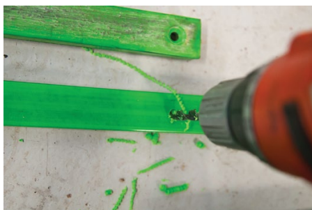
Vi använde de gamla slidsen som mall när de nya hålen borrades.
